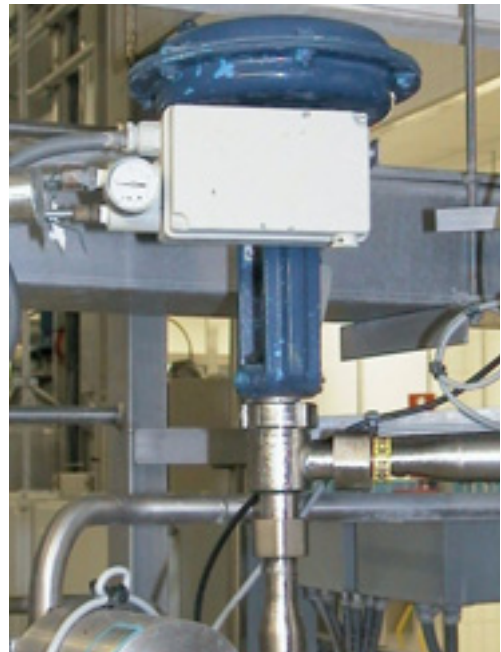
Figuur 498 Regelklep met sanitaire aansluiting
