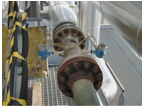
Figuur 318 Flowmeting (Vortex) van een vloeistof (bron: ABB Automation-Businessunit Instrumentation)
