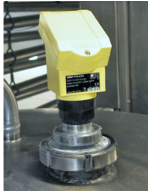
Figuur 243 Druktransmitter capacitief
