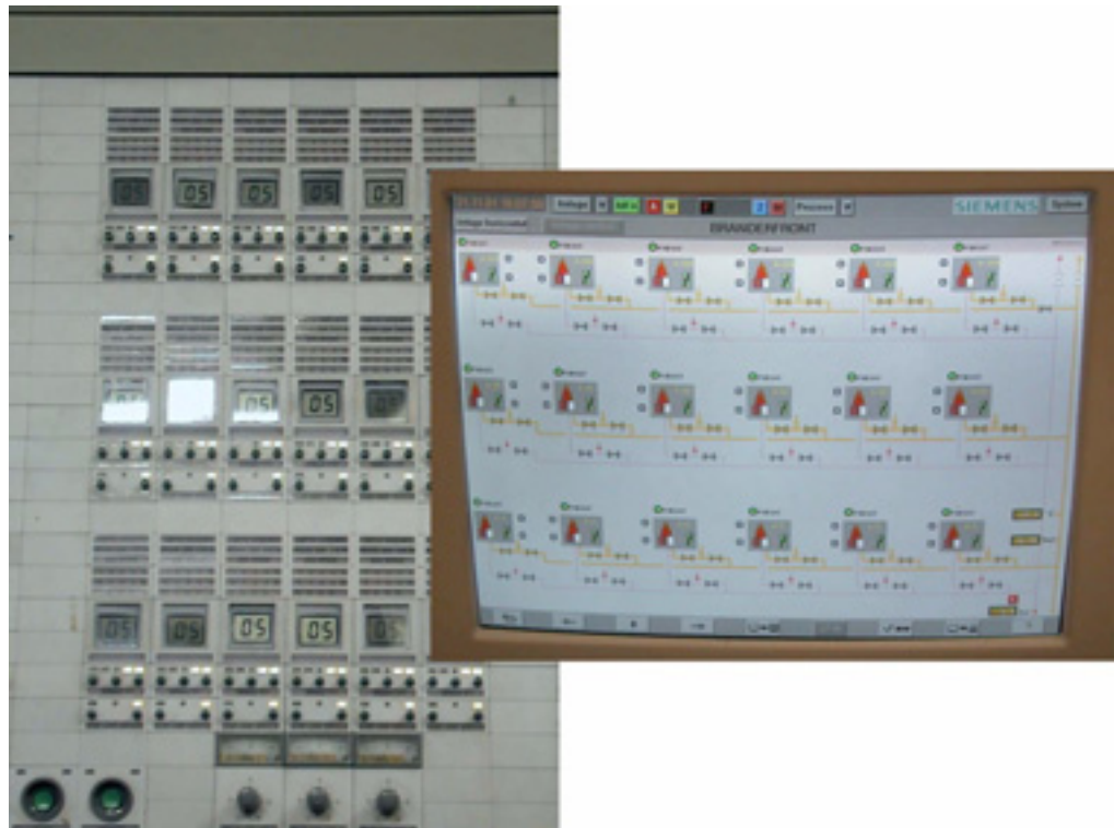
Figuur 581 Bedieningspaneel omgezet naar weergave op een monitor
