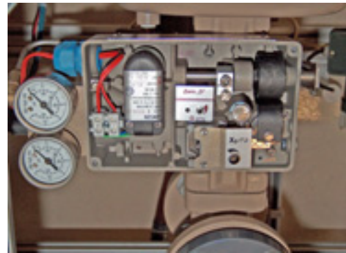
Figuur 513 Instelling zero en versterking
