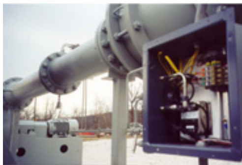
Figuur 319 Flowtransmitter met meetschijf
