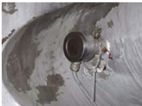
Figuur 388 Pt-100 of thermokoppel opnemer
