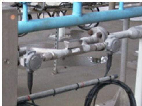
Figuur 370 Ultrasone opnemers recht tegenover elkaar geplaatst, geen reflectie via de buiswand
