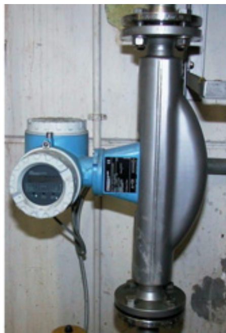
Figuur 378 Aansluiting dubbel gebogen buis
