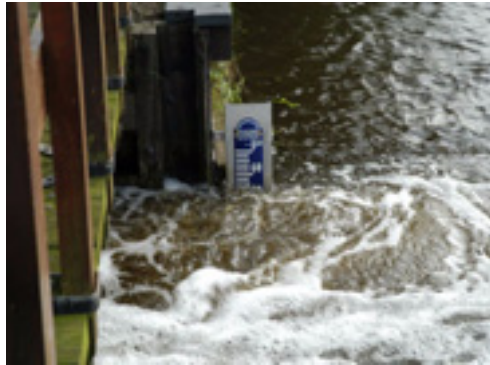
Figuur 265 Niveaumeting met peilstok
