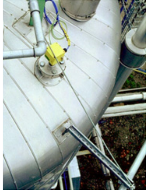
Figuur 263 Niveautransmitter met capacitieve opnemer (bron: B.V. VEGA meet- en regeltechniek)
