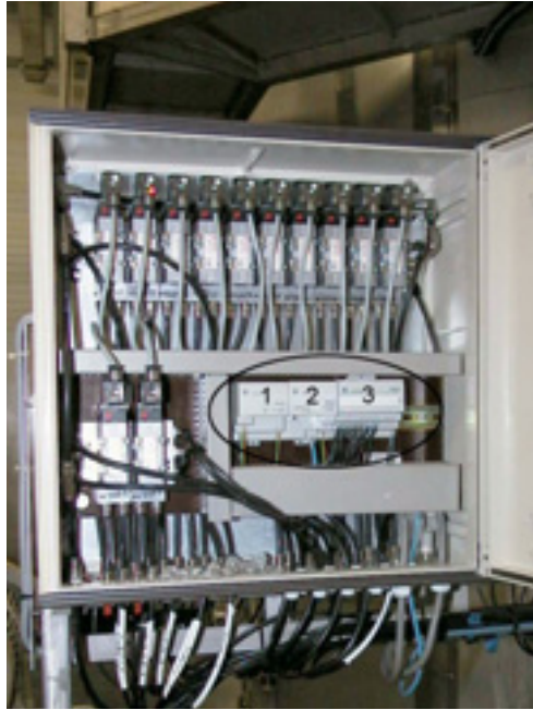
Figuur 593 Junctionbox met ingebouwde I/O module
