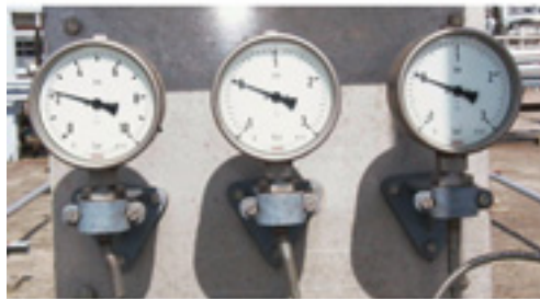
Figuur 246 Manometer met capillaire aansluiting
