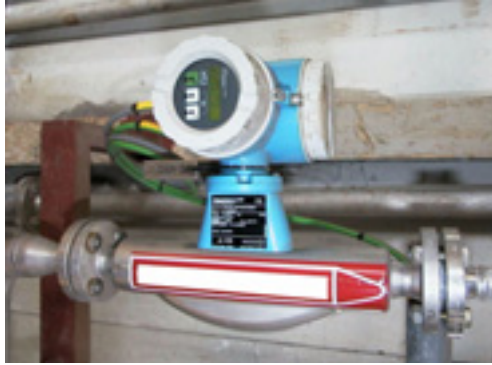
Figuur 371 Massa flowtransmitter
