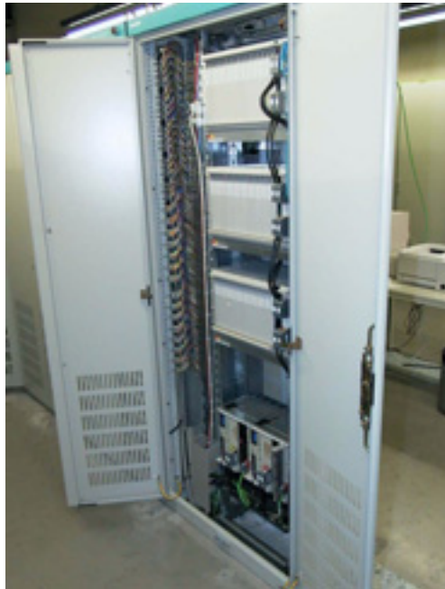
Figuur 574 Kast met meerdere I/O -racks en procescomputer
