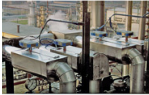
Figuur 317 Flowmeting (Vortex) van stoom (bron: ABB Automation-Businessunit Instrumentation)
