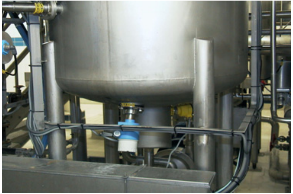
Figuur 114 Buffertank met niveauopnemer
