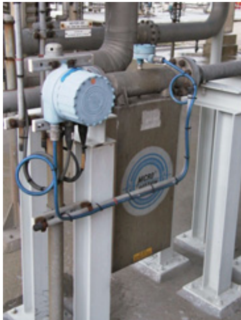
Figuur 377 Aansluiting U-buis
