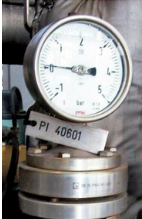
Figuur 224 Manometer met scheidingsmembraan
